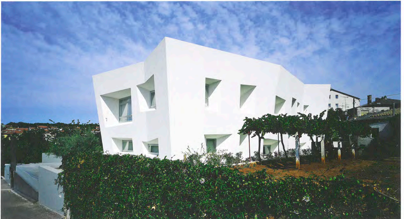
Blick auf kroatischen Firmensitz Lumenart: ein einfacher Kubus auf einem Sockel mit Ziegelwänden, innen und außen verkleidet View of Lumenart's Croatian headquarters: a simple cube on a plinth with walls of clay blocks, clad on the inside and outside
