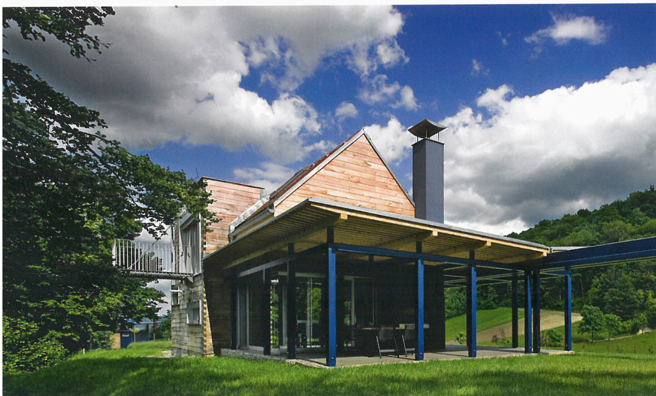
Suvremena interpretacija tradicionalnog motiva: natkrivena zapadna terasa i južna veranda ladanjske kuće na sjeveru Hrvatske počivaju na plavo lakiranoj čeličnoj konstrukciji.
